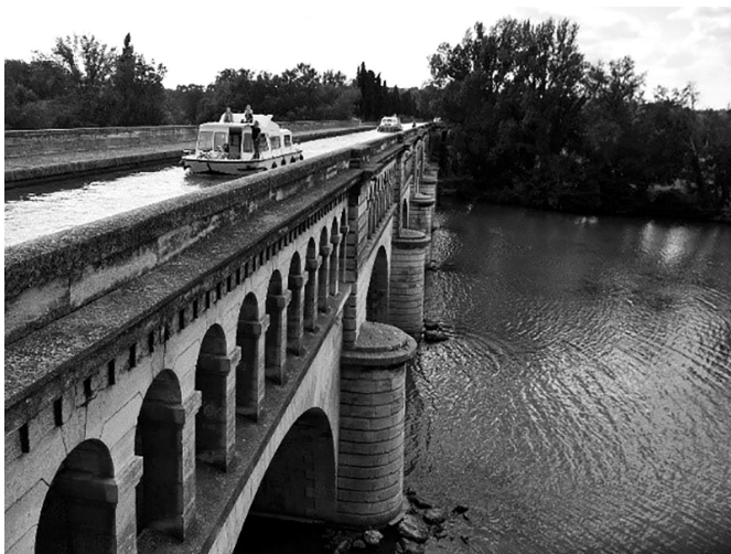
FIGURA 4 Puente del canal sobre el río Orb
