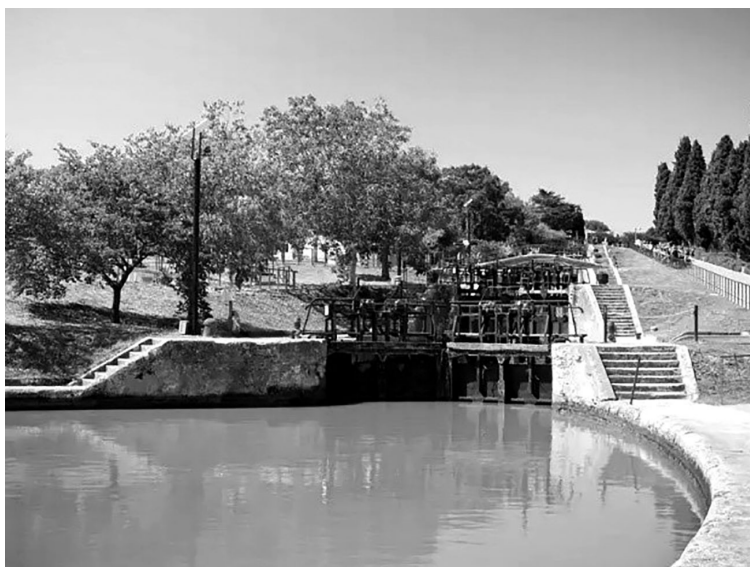
FIGURA 3 La escalera de agua-esclusa de Fonsérane en Béziers
