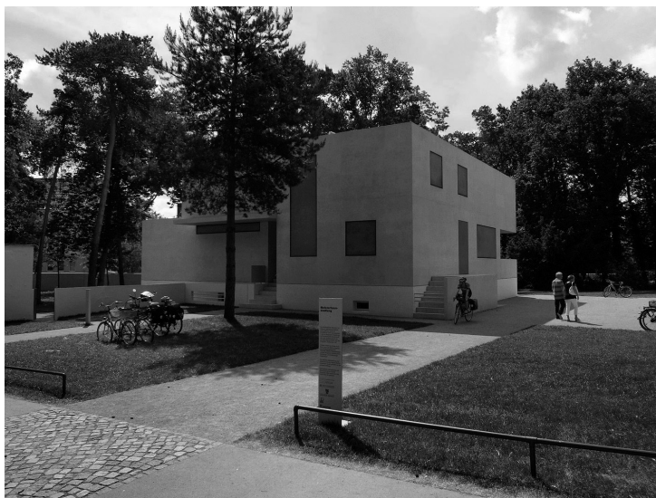
Casa Gropius, parte del conjunto “Casas de los Maestros de la Bauhaus”. Arquitecto: Walter Gropius. Reconstruida en 2014.
